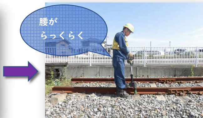
アタッチメントを装着しての作業
